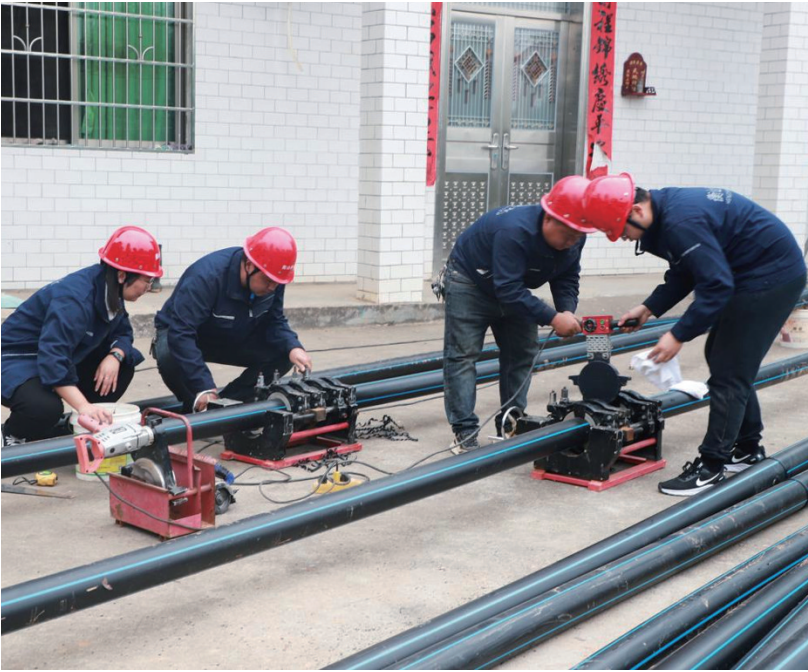
饮水安全整改现场。
