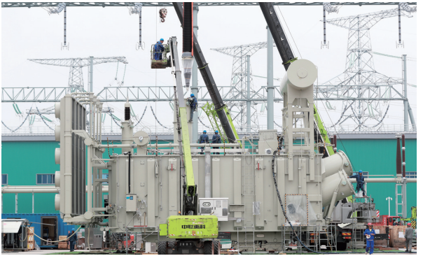
宁电入湘衡阳站±800千伏特高压换流变压器。
