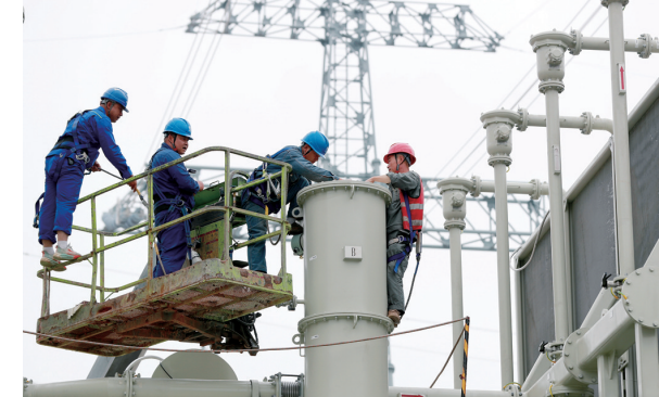
工人们正在安装新到站的高端换流变压器。
