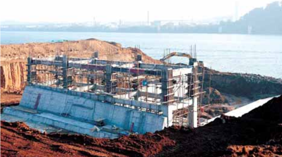
铜桥港闸改扩建工程建设现场。
