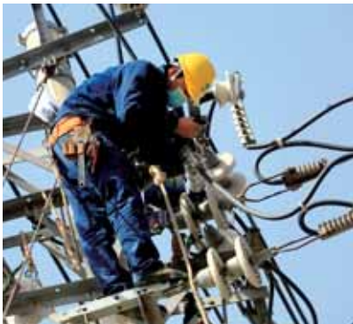
精准定位电网故障, 然后进行维修。
