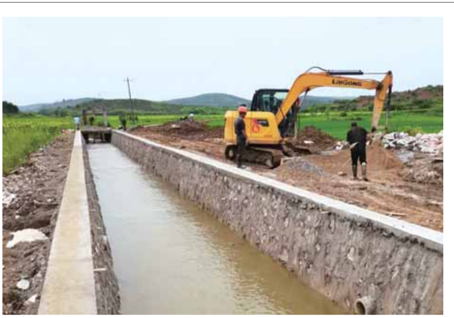
6月27日，由常宁市城投公司施工的烟洲镇石岭大新湾高标准农田建设项目正在抢抓耕桥和水闸，常宁市乡村振兴事务中心对项目施工抓质量、抓进度，力求让农民种烟后不误农时。
