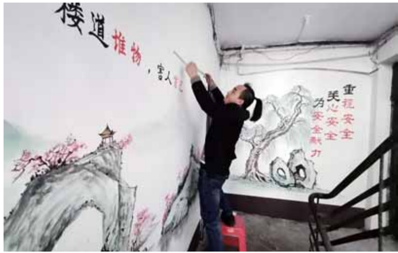
苏眼井社区一处楼道口正在“亮化”中。
