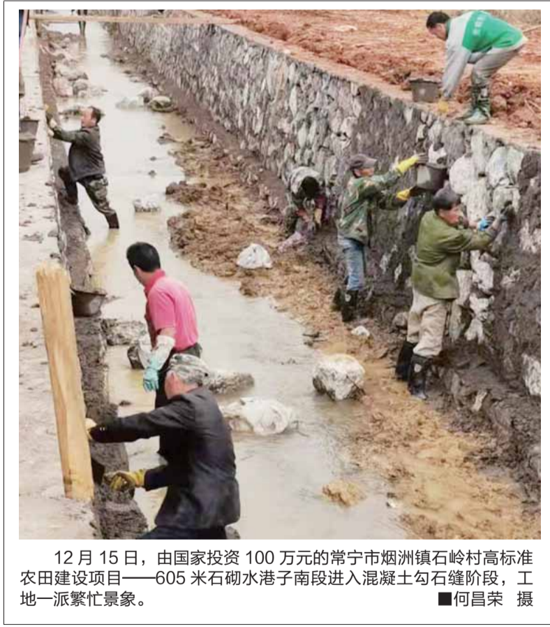
12月15日，由国家投资100万元的常宁市烟洲镇石岭村高标准农田建设项目——605米石砌水巷子南段进入混凝土勾石缝阶段，工地一派繁忙景象。 ■何昌荣 摄
