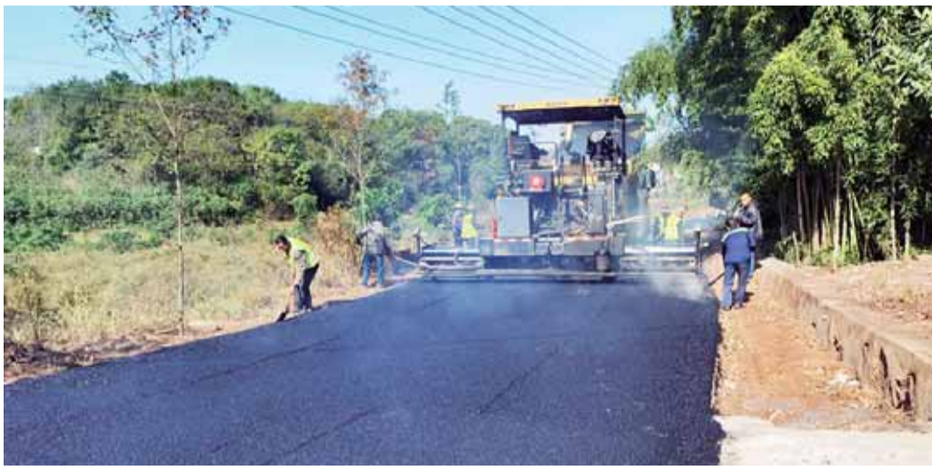
施工人员正在加紧作业。
