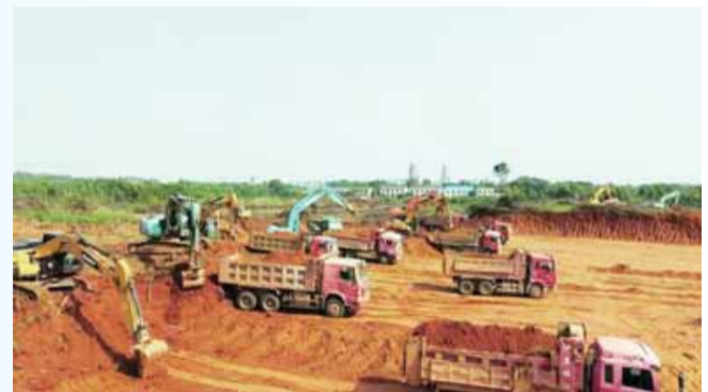
项目现场图（摄于2020年5月）。
