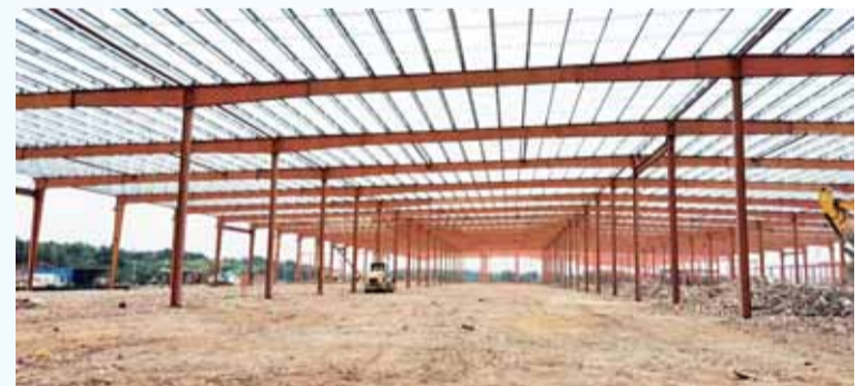
项目现场图（摄于2021年9月）。
