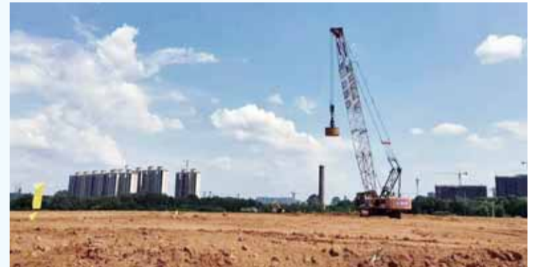
项目现场图（摄于2021年6月）。
