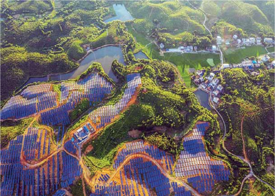
常宁市西岭镇小松柏村光伏发电场，夏季风光如画，引来众多摄影爱好者航拍。小松柏村光伏发电场是“点亮常宁”集中式光伏扶贫电站重点项目，引入投资1.4亿元，装机容量20兆瓦；二期预计投资4亿余元，装机容量达50兆瓦。目前二期投资已经接近尾声。
