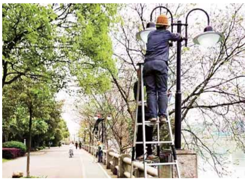
施工人员正在更换庭院灯
