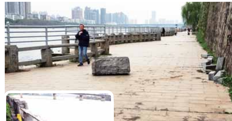
护栏缺口处被锥筒围挡
