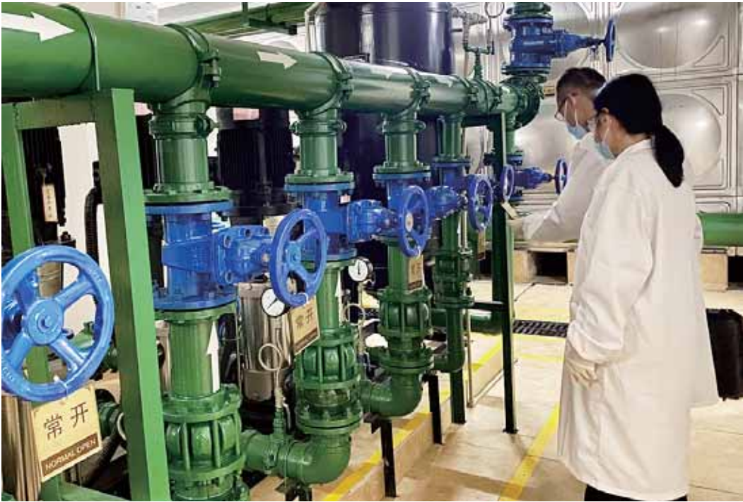
对楼盘泵房的卫生和管材情况进行检查
