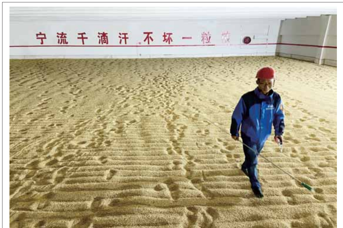
10月16日是世界粮食日，当天，衡阳灵瑞寺国家粮食储备库新库区一位仓管员在粮仓内巡查。据了解，在这里粮食从装卸到入库全部实现自动化，储粮实现机械通风、微机测温、环流熏蒸、空调恒温、远程监控五个100%，仓容量扩大到50.5万吨，成为湘南地区规模最大的粮食仓储基地。 ■本报记者 彭斌 摄
