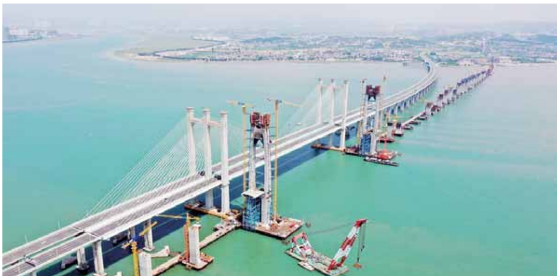
施工中的新建福州铁路泉州湾跨海大桥南岸主塔
