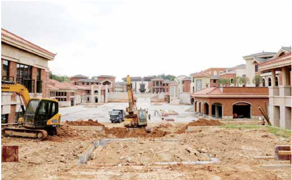
正在进行园区户外景观的施工
