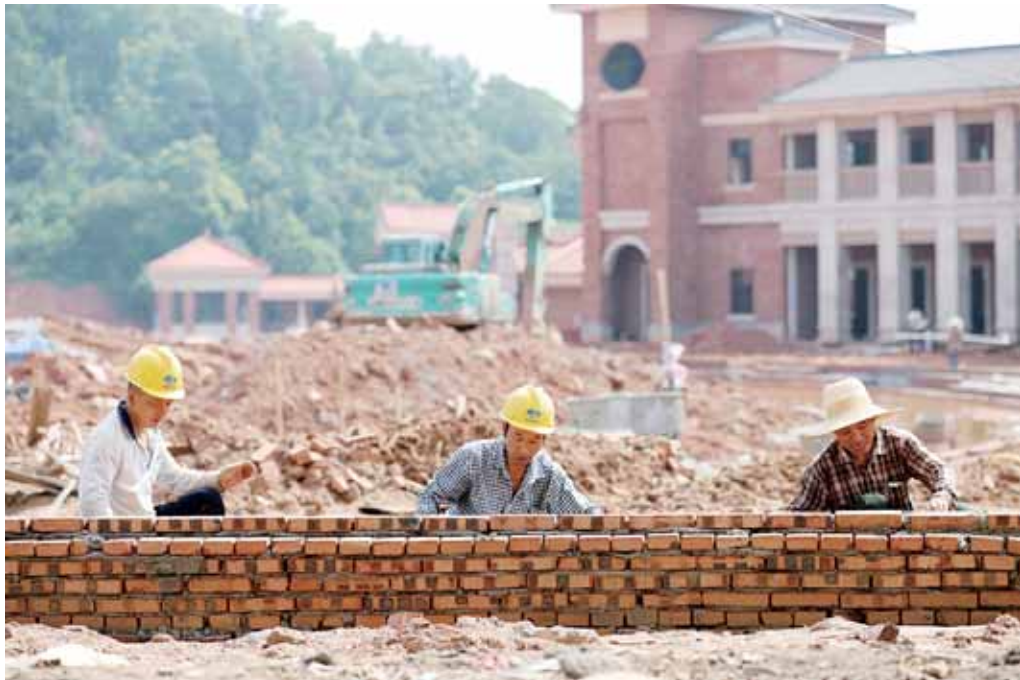
项目建设现场如火如荼
