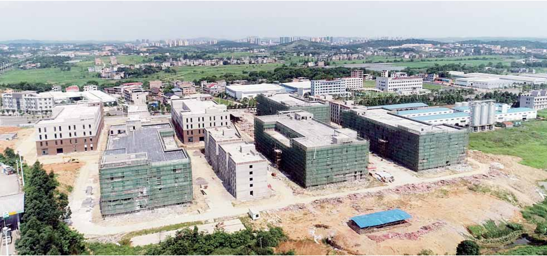
12 栋已封顶的厂房整齐排列
