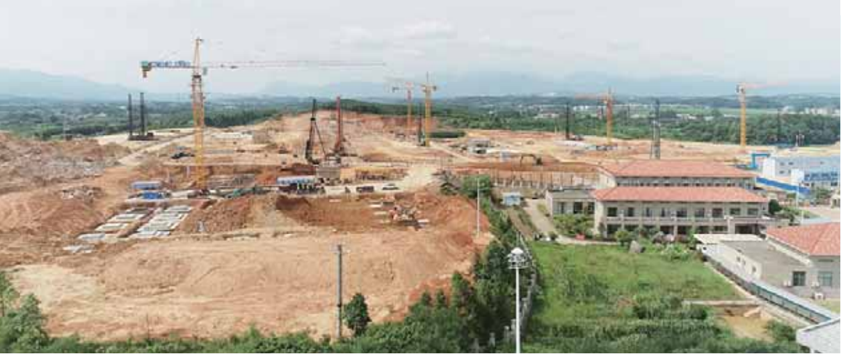
34 栋厂房全面开工
