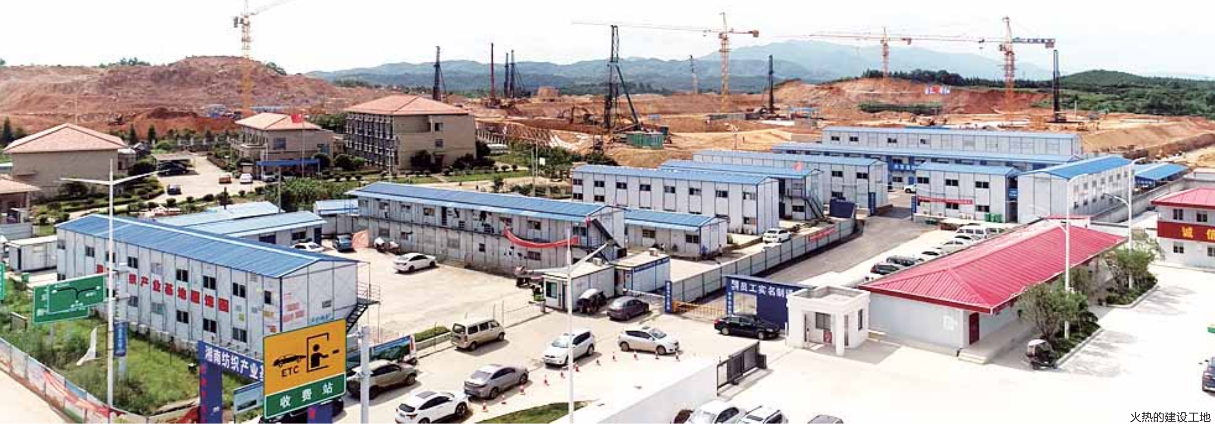
火热的建设工地
