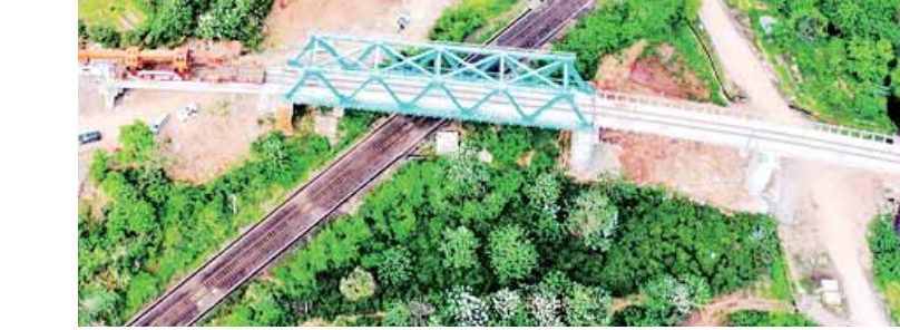
4月18日，在金华铁路永康江特大桥建设现场，工人们在架设最后一孔预制T梁（无人机照片）。当日，浙江金华至台州铁路永康江特大桥顺利贯通，标志着全线进入到500米长钢轨换铺阶段。永康江特大桥位于浙江省金华市武义县与永康市交界处，全长8355.39米，是金台铁路全线最长桥梁。 （新华社发）
