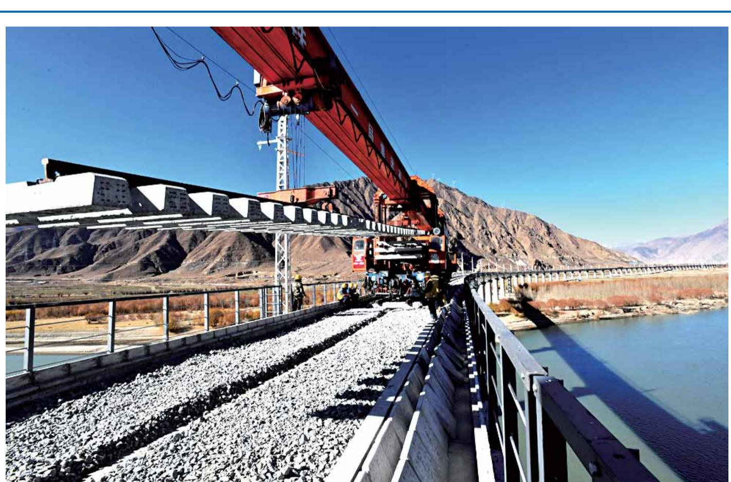
12月1日，中铁十一局铺架队工人在进行拉林铁路第二次跨越雅鲁藏布江的铺轨。当日，位于西藏山南市桑日县绒乡附近的拉林铁路绒乡雅鲁藏布江特大桥完成铺轨，这是拉林铁路第二次跨越雅鲁藏布江。绒乡雅鲁藏布江特大桥全长4615米。拉林（拉萨至林芝）铁路全长435.48公里，设计时速160公里，是西藏首条电气化铁路，共跨越雅鲁藏布江16次。自2018年10月正式铺架至今，已完成铺轨114公里，预计2020年底完成全线铺架。
