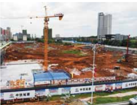
建设中的总部基地
