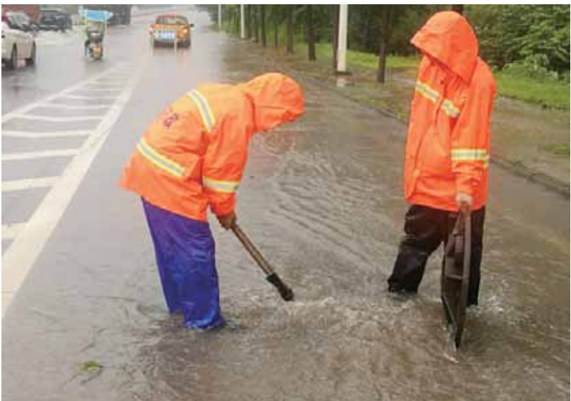
排水人员撬开下水道盖板
