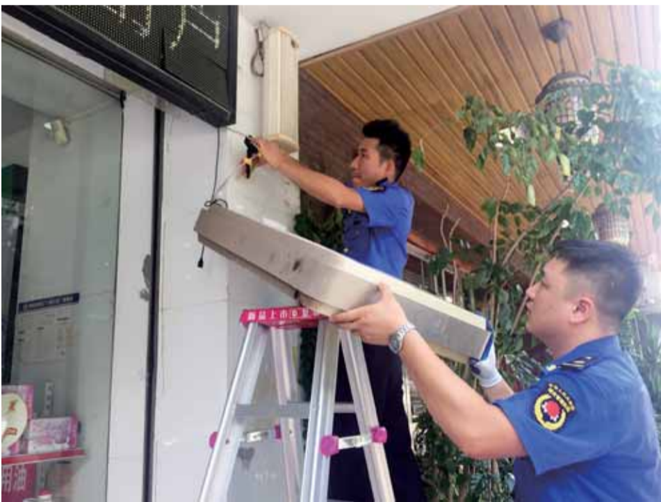
拆除违章广告牌
