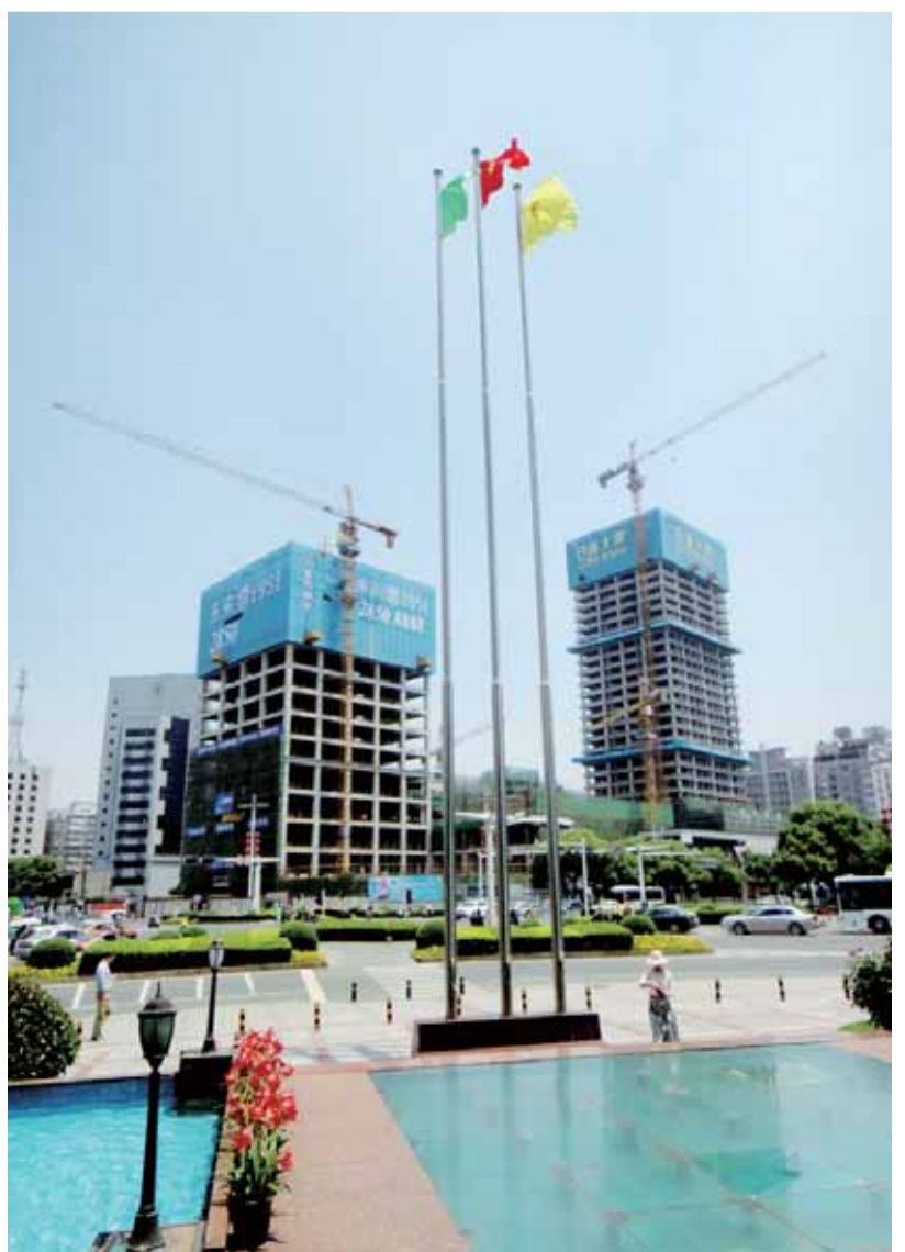
能拆卸、能升降、反复使用、节能减排的“爬架”
