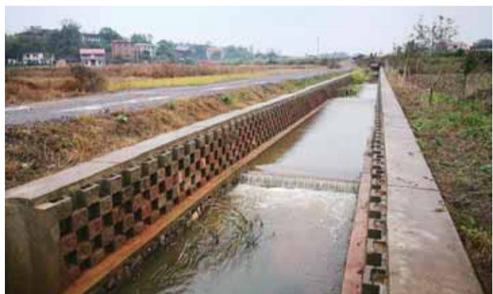
生态渠底部不封底，两侧用生态砖做护坡
