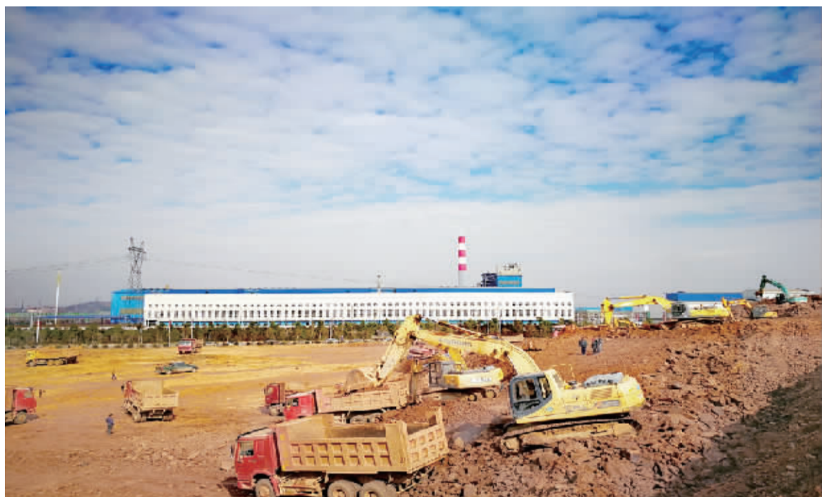
今年 11 月 29 日, 株冶集团正式落户水口山经开区, 计划投资约 80 亿元, 按“30+30+10”的铜铅锌产业布局, 形成年产值 200 亿元的国家大型有色金属产业基地。目前, 铜铅锌基地项目正开足马力建设, 预计明年 12 月投产。图为该项目热火朝天的建设场景。 彭新霖 摄
