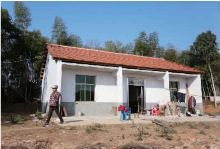
茶山垌镇已完成的贫困户危房改造项目
