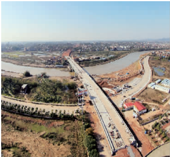
船山西路蒸水河大桥“已见雏形”
