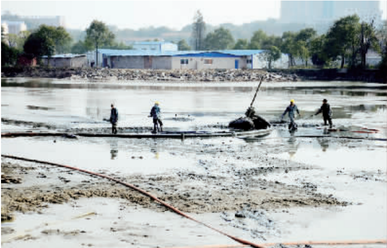
专业施工队伍正在对酃湖公园湖底淤泥进行消毒除菌处理。酃湖公园将建设成为一个集吃、住、游、购、娱为一体的大型综合性公园。
