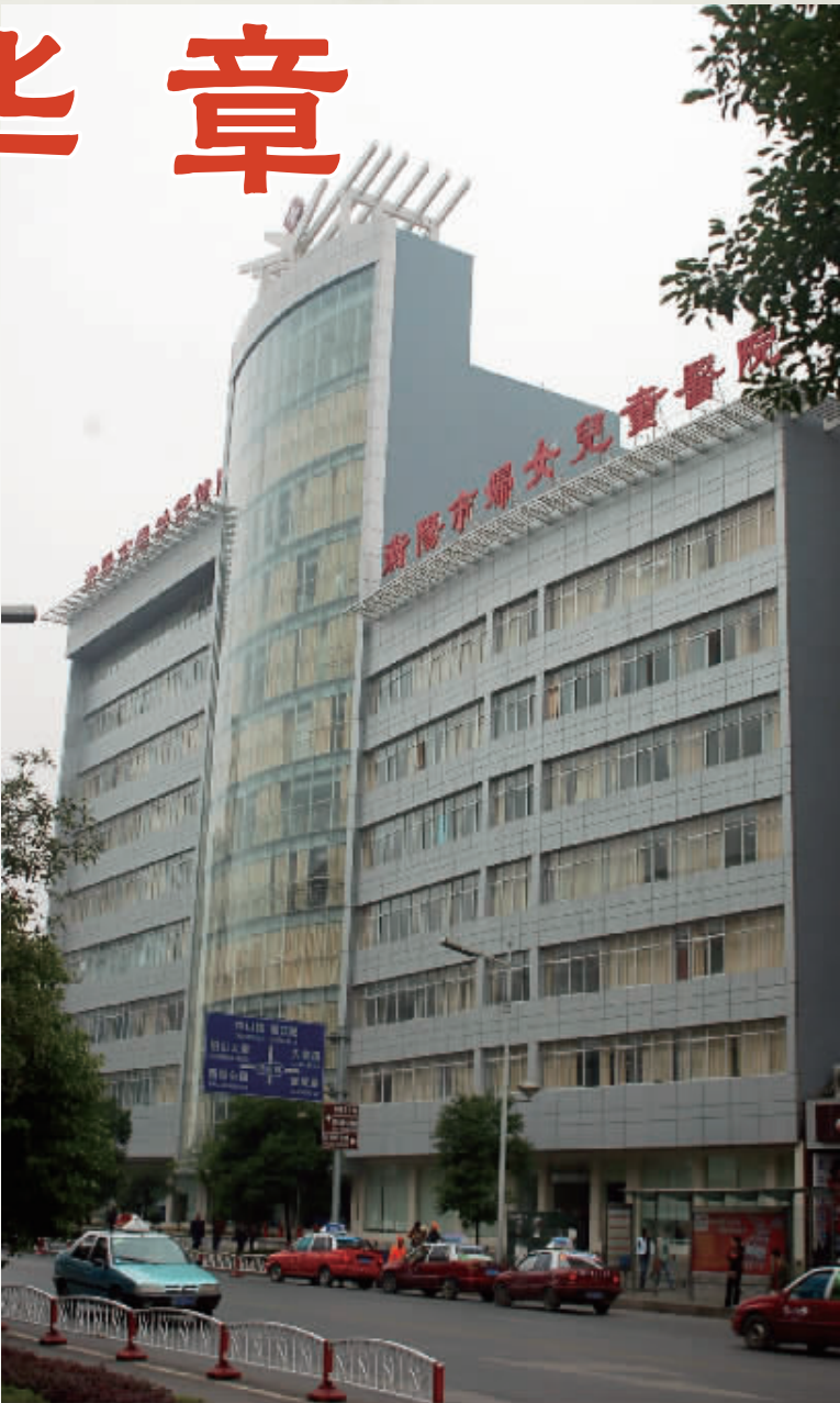
现代化的门诊、住院综合楼拔地而起。
