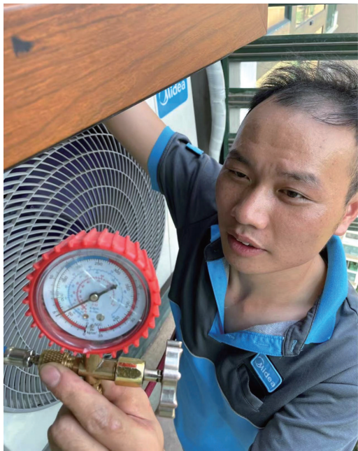
欧华锋在高层外墙进行空调安装作业。
