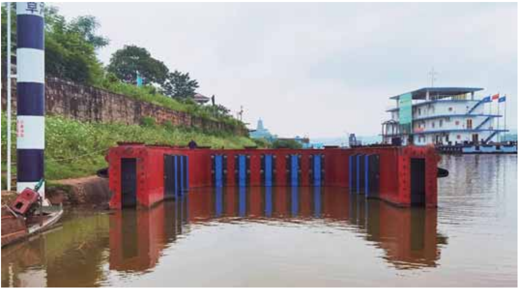
桥梁防撞墩被成功拦截缚住，安全隐患消除。
