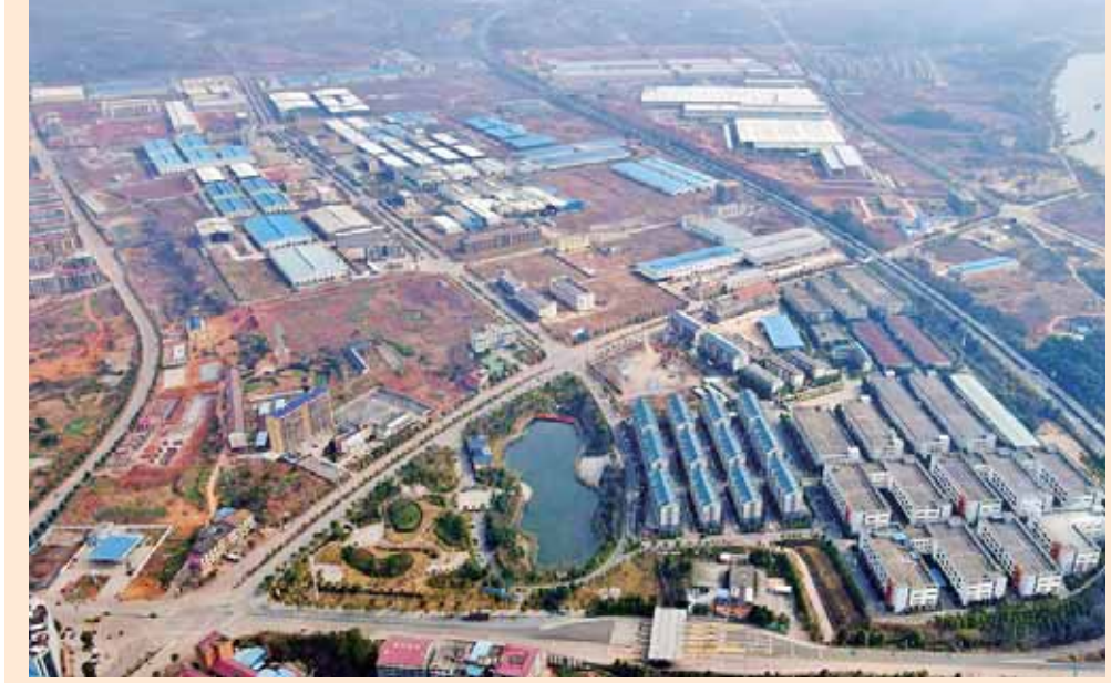
建设中的新能源汽车产业项目。
