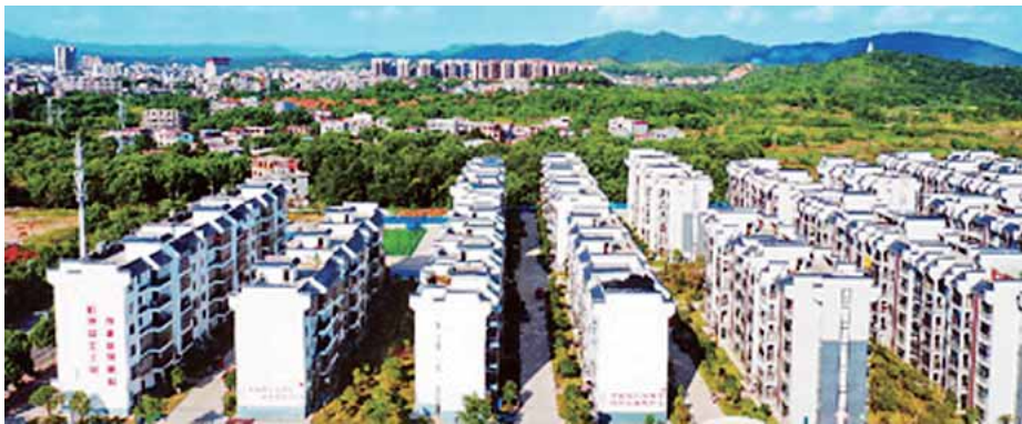
湖南省永州市新田县近年来在解决易地扶贫搬迁户住房问题的同时,注重满足搬迁户的就业、就医、入学等生活配套问题。图为新田县工业园易地扶贫搬迁集中安置点。
