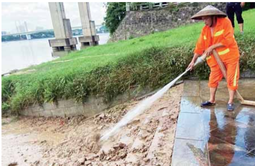
环卫工人利用高压水枪冲洗亲水平台淤泥
