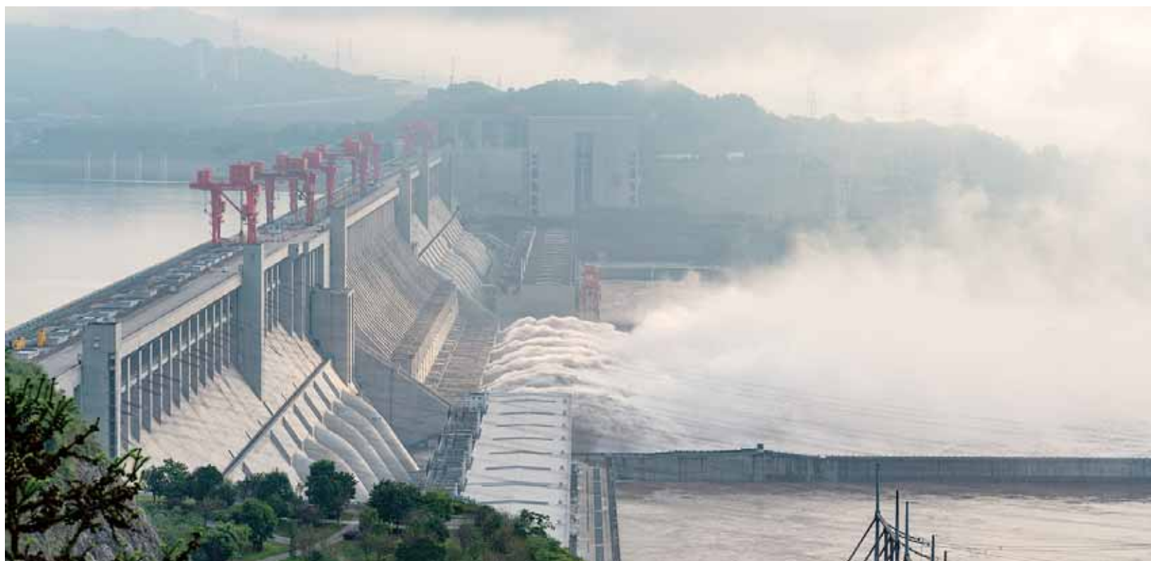
8 月 18 日拍摄的长江三峡枢纽工程开启泄洪深孔泄洪的情景
