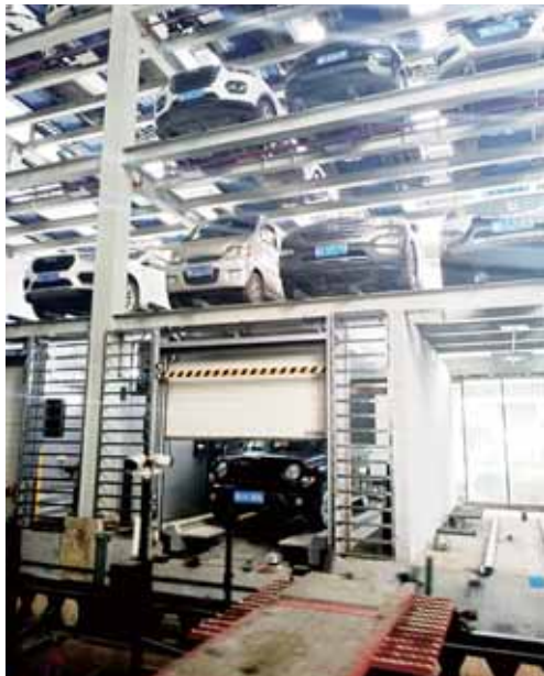
三维空间立体停车库,实现“向上要空间”的突破
