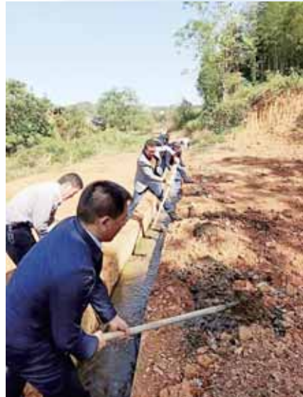
扶贫工作队与村组干部一道正在修葺水渠
