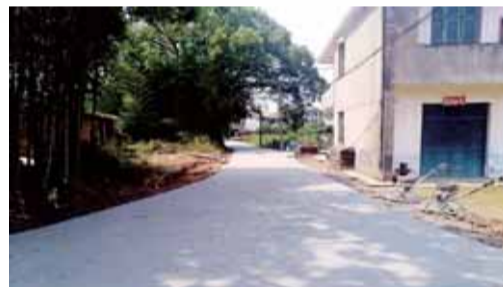
硬化通组入户公路3800米
