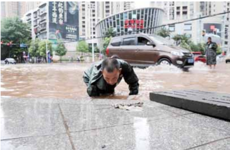
在积水严重的地方,排水人员临时揭开下水管道挡板,并蹲点守候排水口
