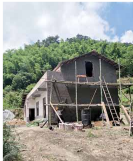
贫困户房屋整体修缮中
