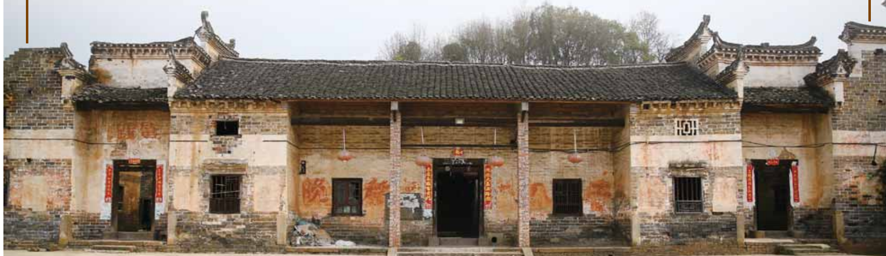
位于坪上村的清代直隶州判刘振德故宅
