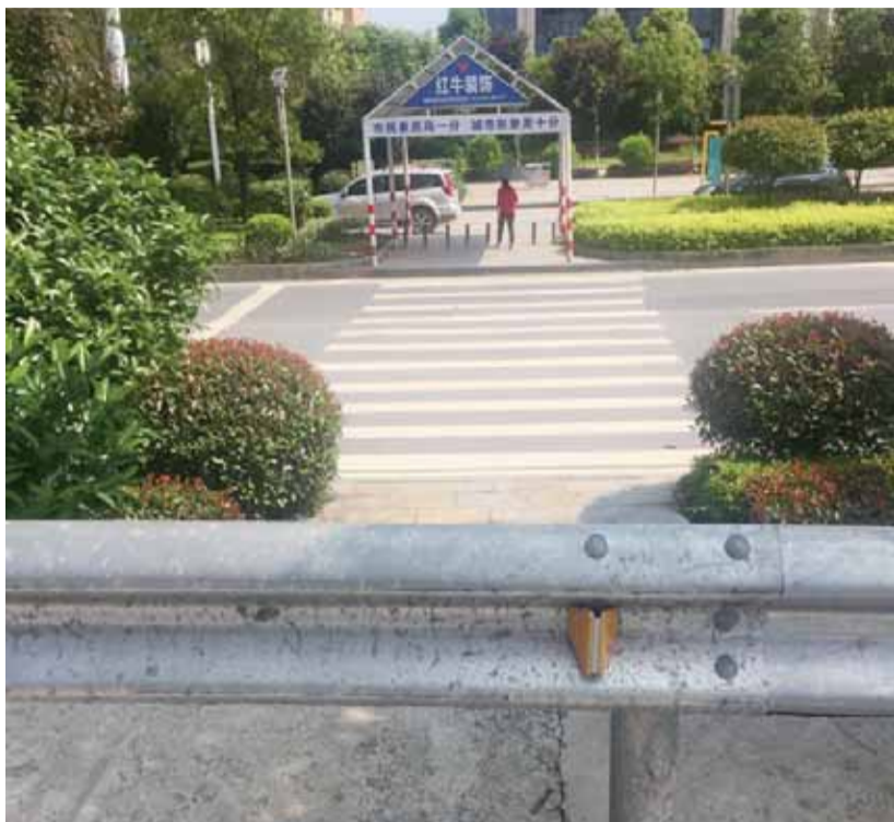
在万达广场前的马路上，俯拍“断头”斑马线
