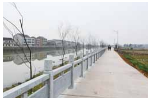
去年12月竣工的渣江镇东洲村蒸水河西堤风光带，全长800米
