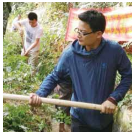
帮助村里疏通水渠
