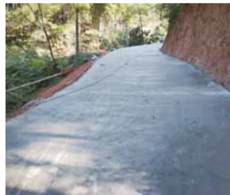
新修的1.5公里扶贫道路
