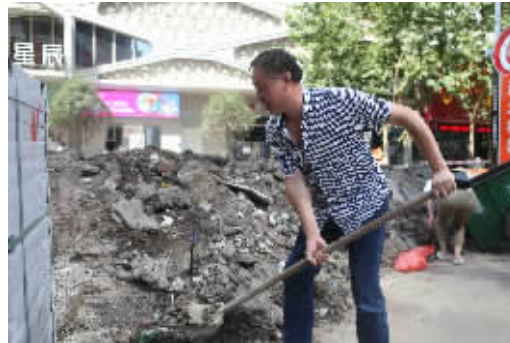
包路段单位人员帮助清理施工路段建筑垃圾。
