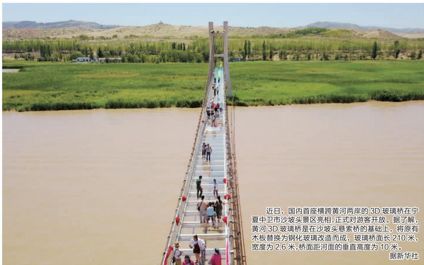
近日，国内首座横跨黄河两岸的 3D 玻璃桥在宁夏中卫市沙坡头景区亮相，正式对游客开放。据了解，黄河 3D 玻璃桥是在沙坡头悬索桥的基础上，将原有木板替换为钢化玻璃改造而成，玻璃桥面长 210 米，宽度为 2.6 米，桥面距河面的垂直高度为 10 米。
