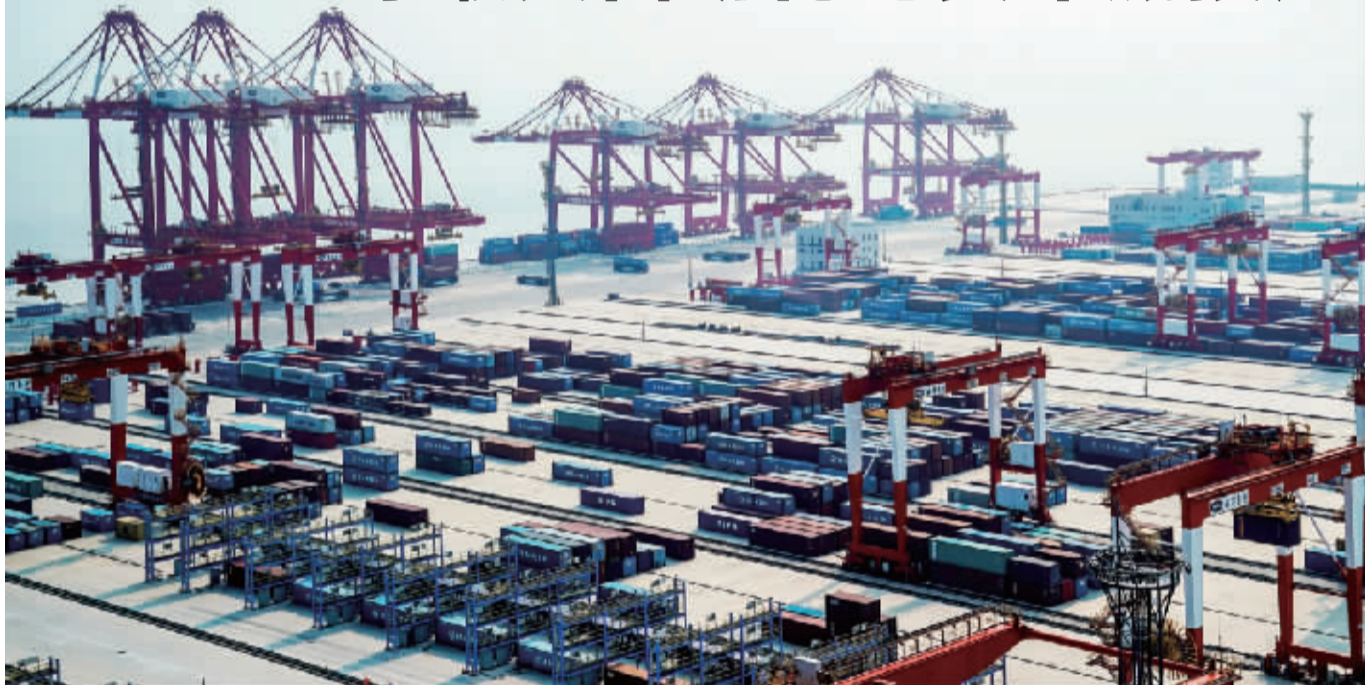
正在建设中的全球最大集装箱全自动化码头——上海洋山深水港四期工程目前已进入最后的设备安装和调试阶段,计划年底开港试运营。 据新华社
