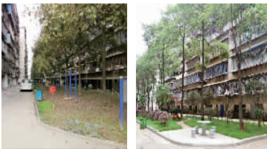
改造前的衡阳电信小区
